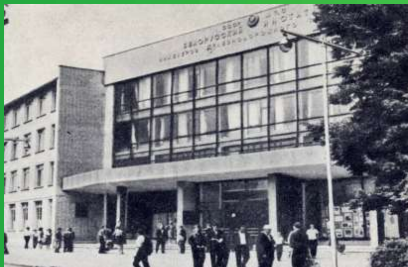
Белорусский институт инженеров железнодорожного транспорта в г.Гомеле
